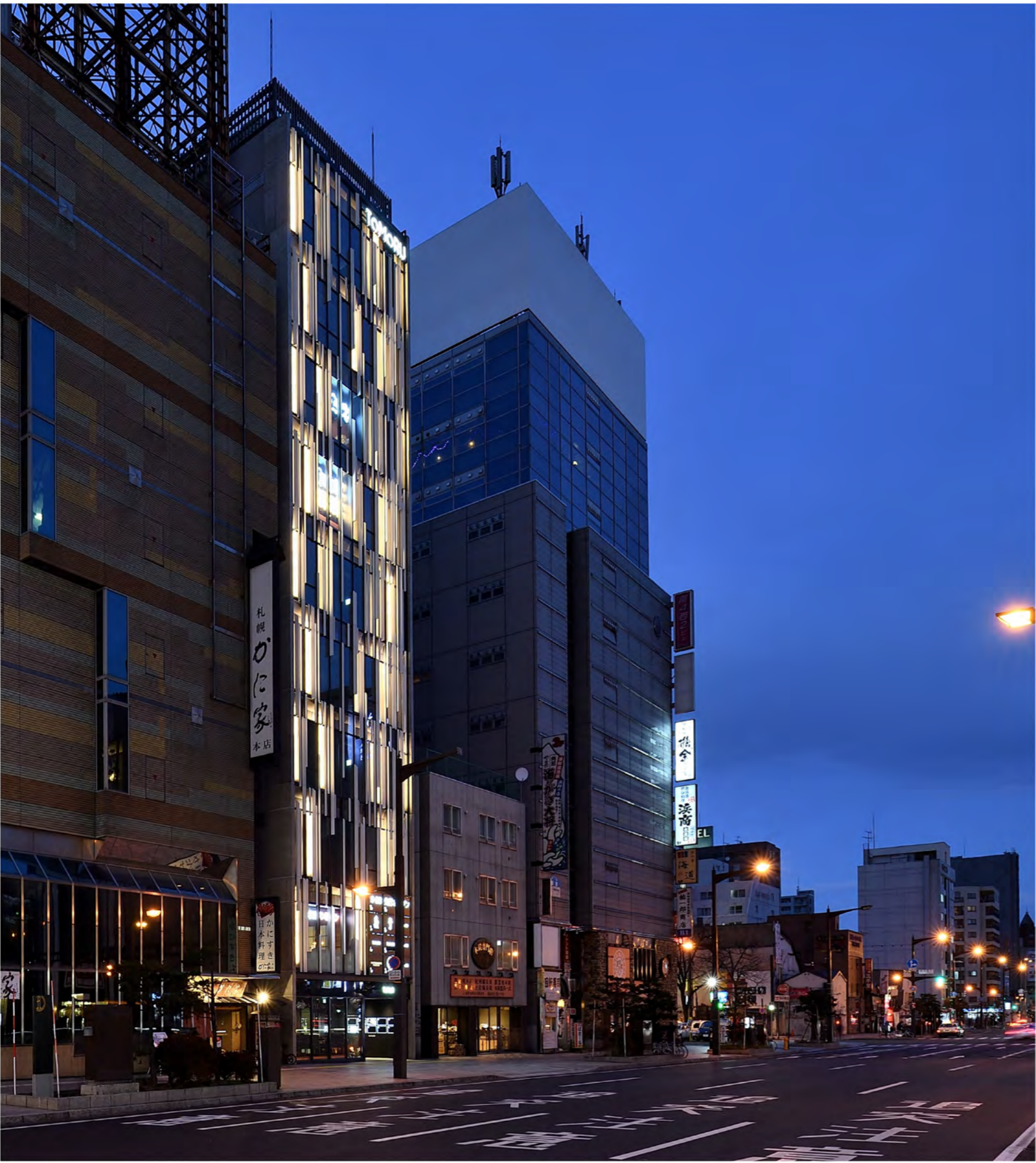
ファサード照明廻り 照明器具と遮光板の形状を工夫し、バックパネルにシャンパンゴールドの光が伸びる
