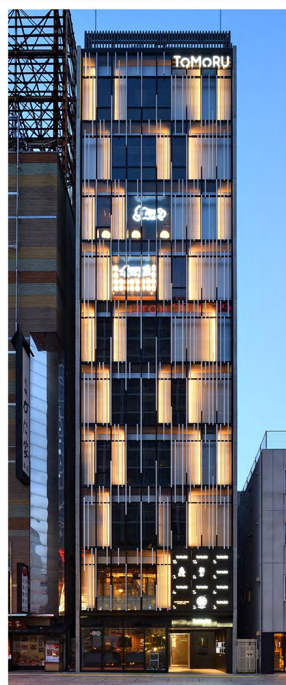
南側外観 調光により照明の明るさに変化をつけ、自然の中の氷柱の不均質な輝きを演出
